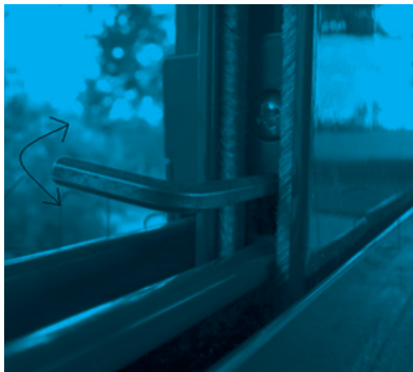
Рис. 6. Регулировка высоты створки
