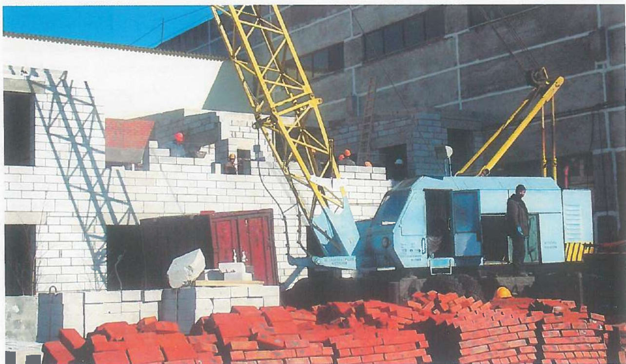
Строительство нового цеха СТЕКЛОКОМА
