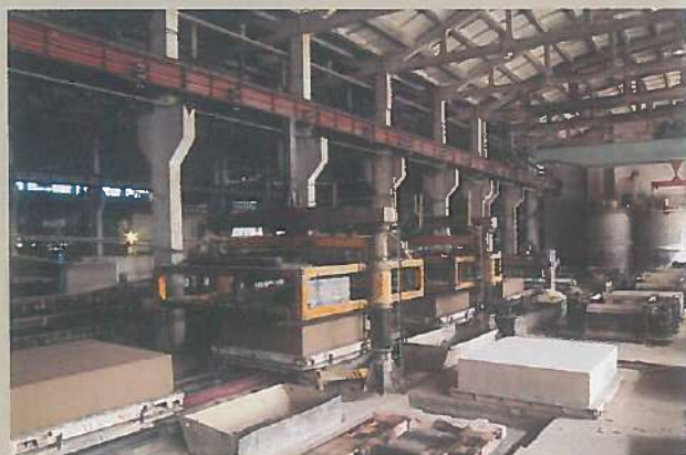
Линия по производству газобетонных блоков
