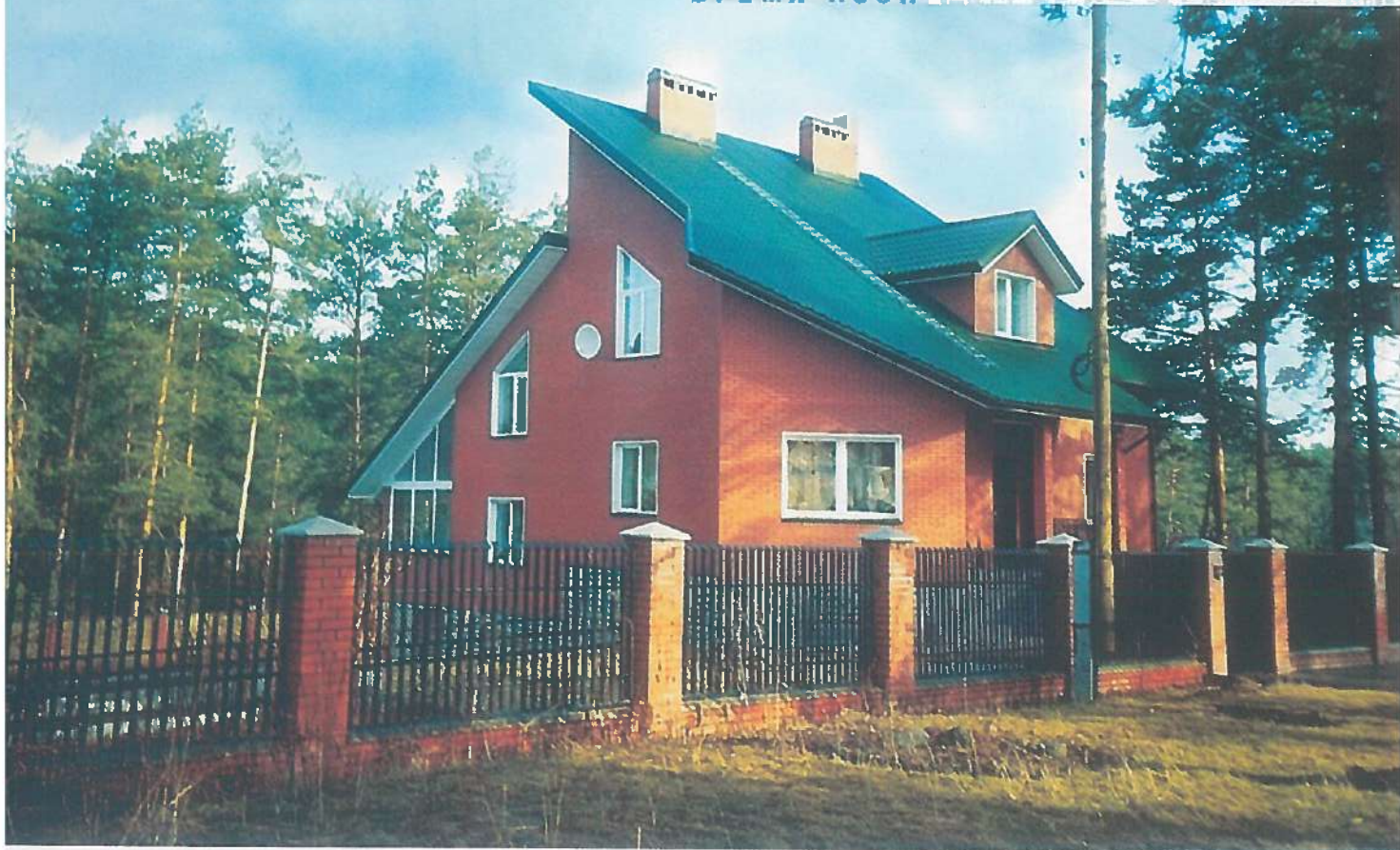
Коттеджи, построенные ПЗСП, отлично вписываются в пейзаж
