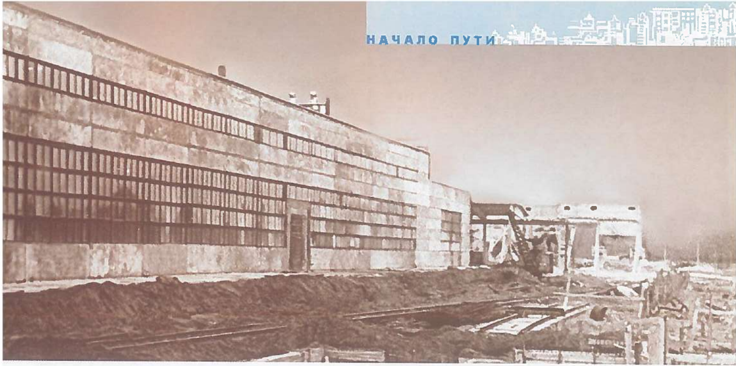
Начало строительства склада цемента. 1965
