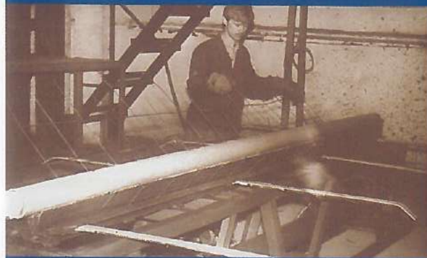
Гибочный станок арматурного цеха
