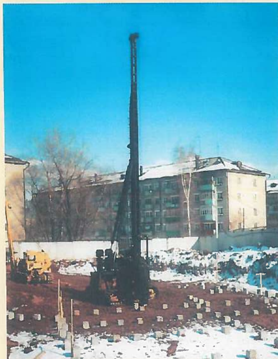
Управление механизацией ведет забивку свайного поля
