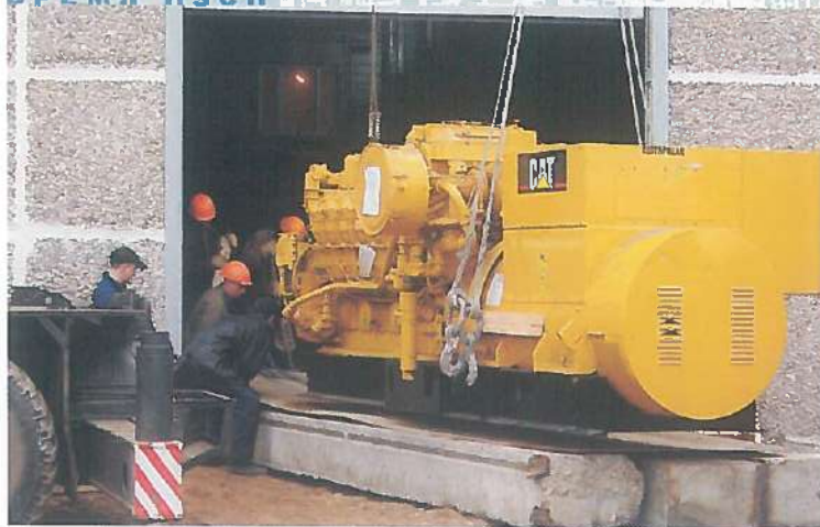
Монтаж электростанции собственных нужд
