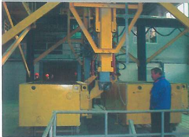
Запуск новой линии газобетонных блоков. 23 ноября 2007 года
