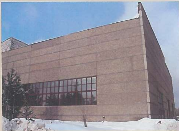
Корпус ремонтно-механического цеха
