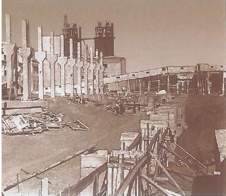
Строительство корпуса цеха силикатных панелей. Октябрь, 1964
