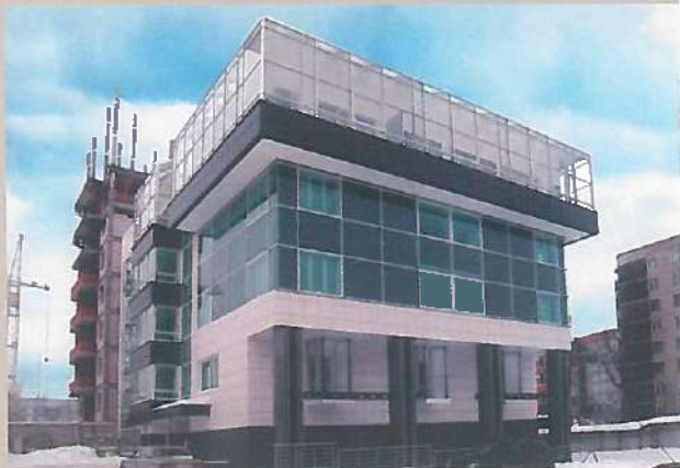
Строительство на ул. Островского (Турчаниновский квартал)
