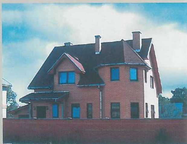
Коттеджи, построенные из блоков ПЗСП
