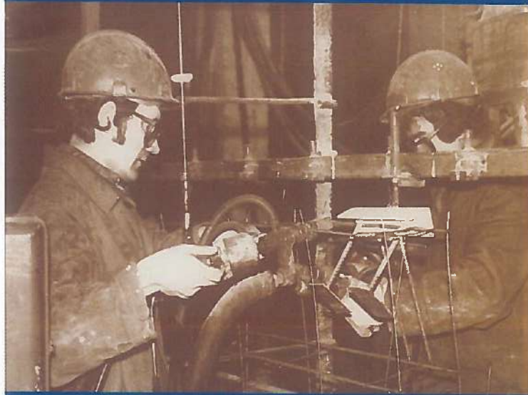
Работы арматурного цеха формируют каркасы
