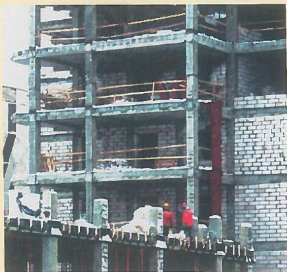
Работы ведет СМУ-2 ПЗСП
