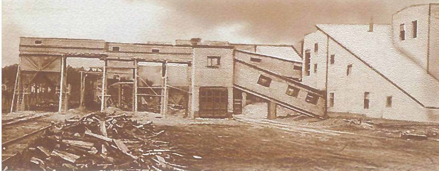
Деревянная эстакада под погрузку извести
