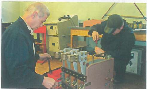
Ветеран труда В. М. Кононов за ремонтом автоматического выключателя
